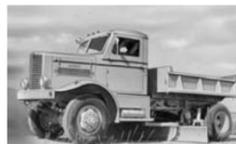
二十世纪三十年代 WT-SERIES卡车诞生。凭借更优秀的舒适性、动力和效率，该卡车将高速扫雪这一新概念引入商用和军用机场
